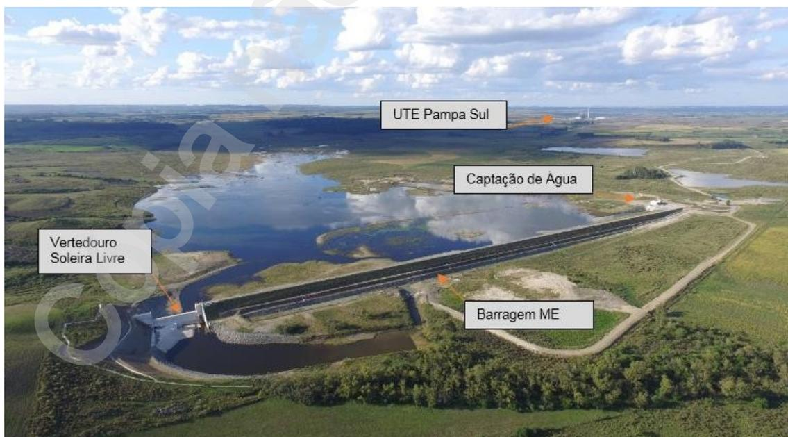
**Figura 2: Arranjo geral das estruturas da barragem Jaguarão 2.**
